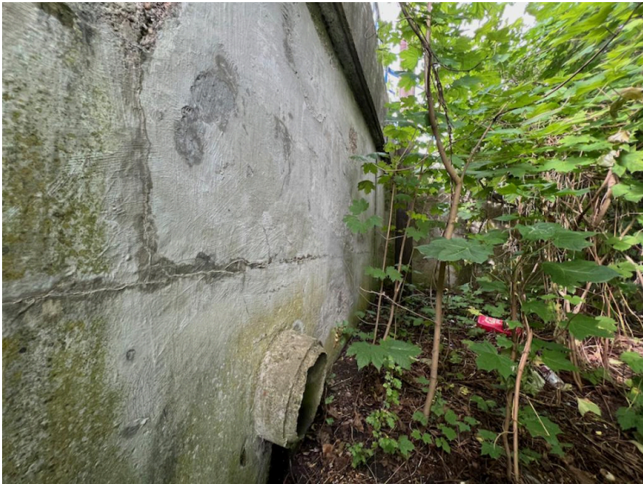
IMG_5385 - na křídle K4 se vyskytují nepravidelné trhliny do 0,3mm, lokálně výluhy
