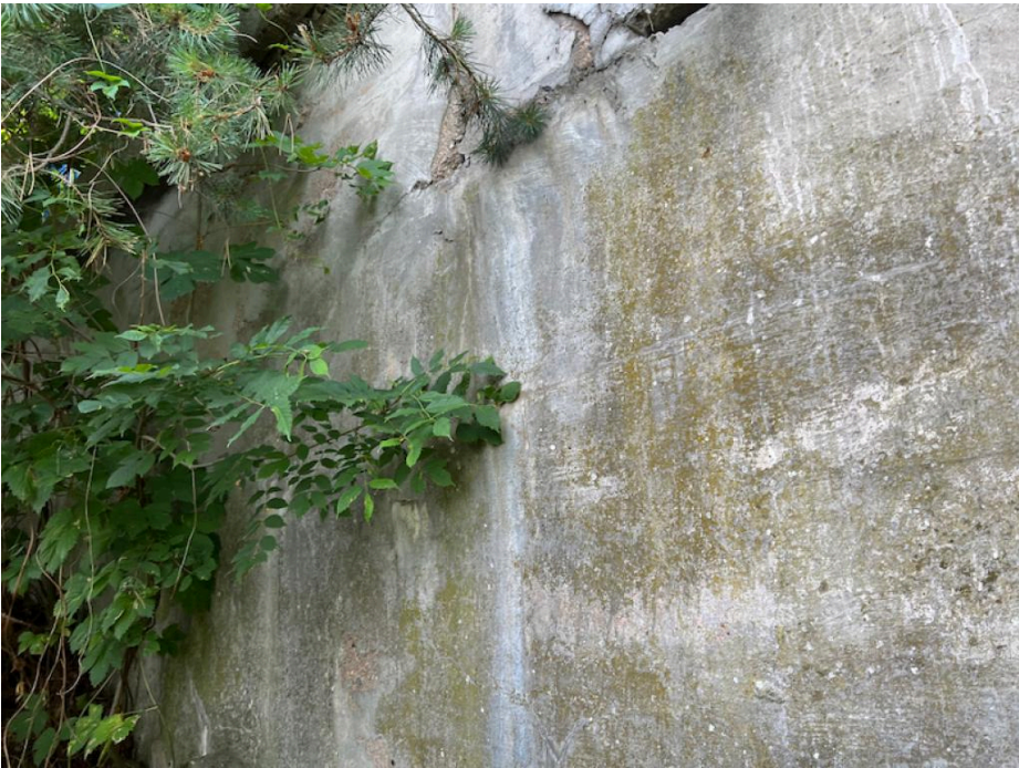
IMG_5355 - na křídlech jsou stopy po zatékání
