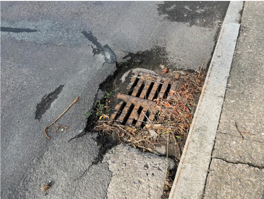
IMG_5299 - vpustě jsou propadlé vůči vozovce až o 50mm
