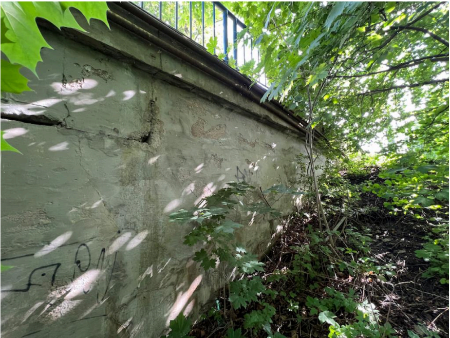
IMG_5334 - povrch křídla K1 povrchově degraduje
