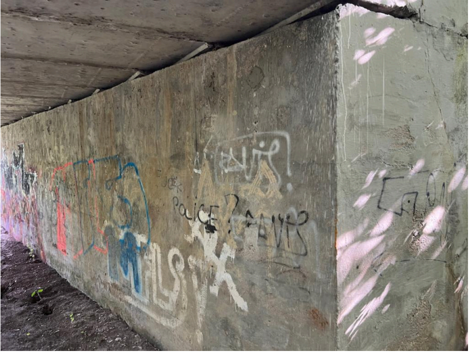
IMG_5346 - na opěře O1 jsou stopy po zatékání
