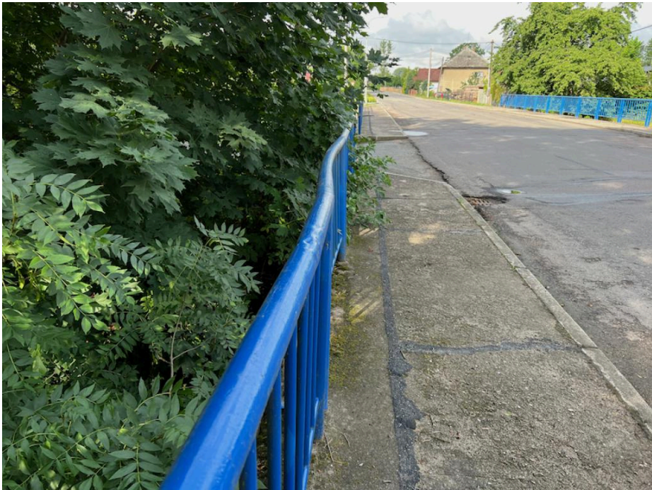
IMG_5314 - levé zábradlí na konci mostu je deformované nárazem
