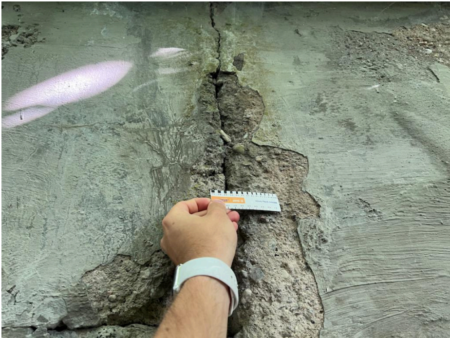
IMG_5340 - otevřená dialtační spára mezi NK a křídlem K1
