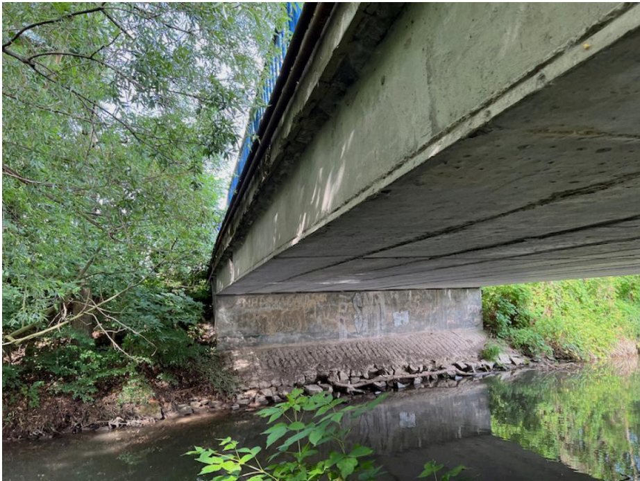
IMG_5359 - poškozená dlažba podél opěr
