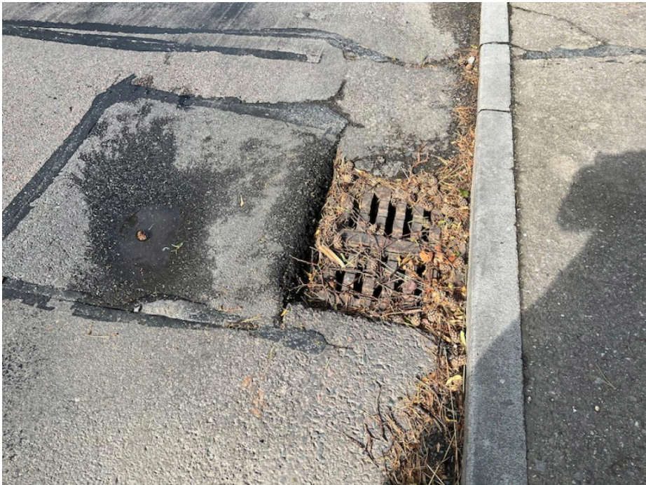
IMG_5292 - vpustě jsou propadlé vůči vozovce až o 50mm
