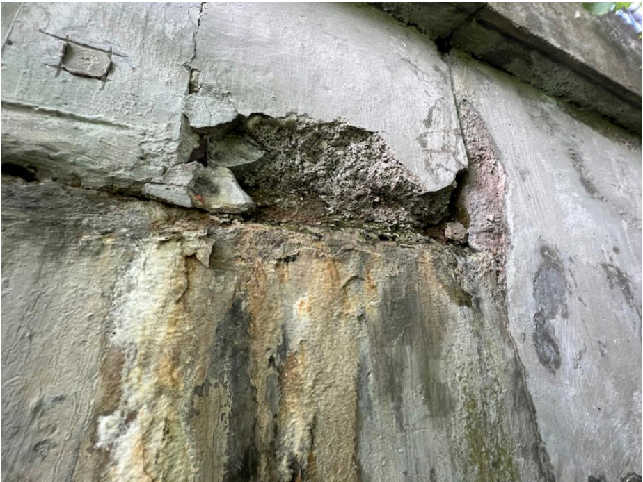
IMG_5382 - koncový příčník na konci mostu vpravo hloubkově degraduje!
