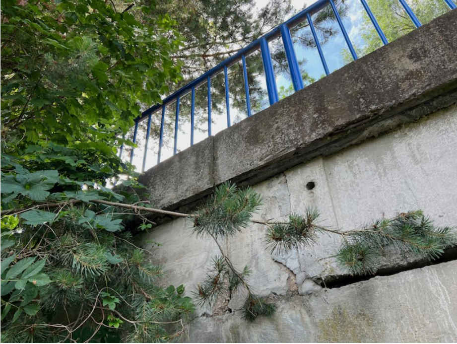
IMG_5357 - povrch křídla K1 povrchově degraduje
