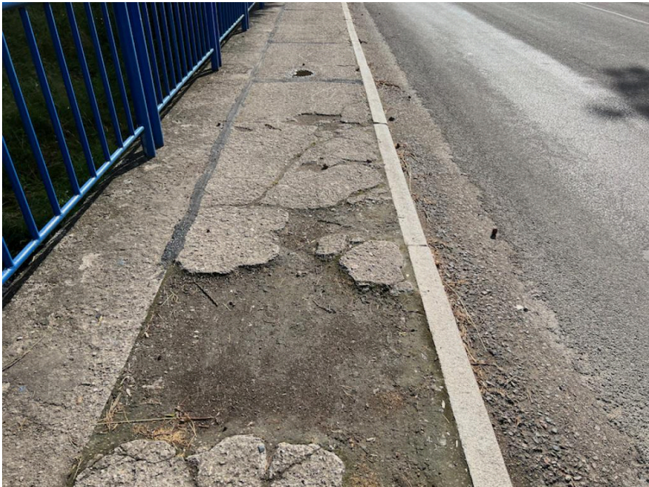
IMG_5323 - povrch pravé římsy hloubkově degraduje
