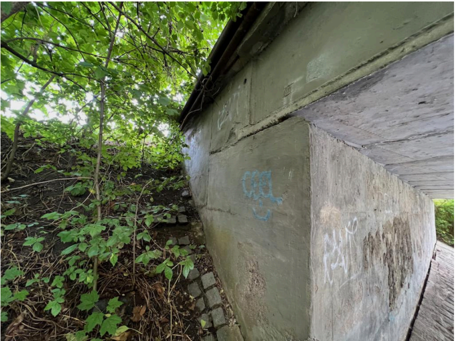
IMG_5368 - povrch křídla K3 povrchově degraduje
