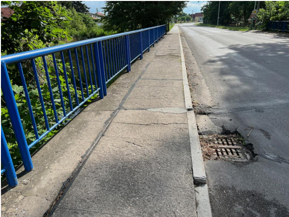
IMG_5320 - na površích říms jsou otevřené trhliny
