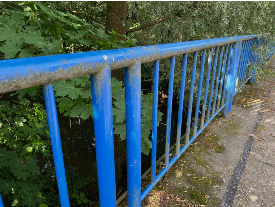
IMG_5309 - PKO zábradlí je dožilá, prozatím bez větší koroze
