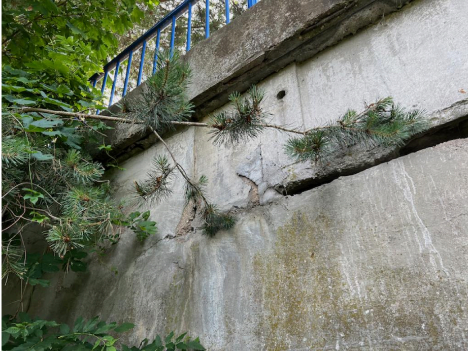
IMG_5356 - povrch křídla K2 povrchově degraduje
