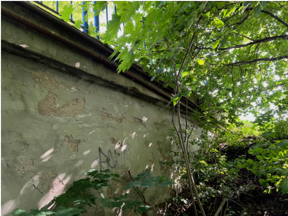
IMG_5336 - povrch křídla K1 povrchově degraduje
