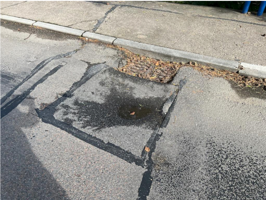
IMG_5291 - vpustě jsou propadlé vůči vozovce až o 50mm
