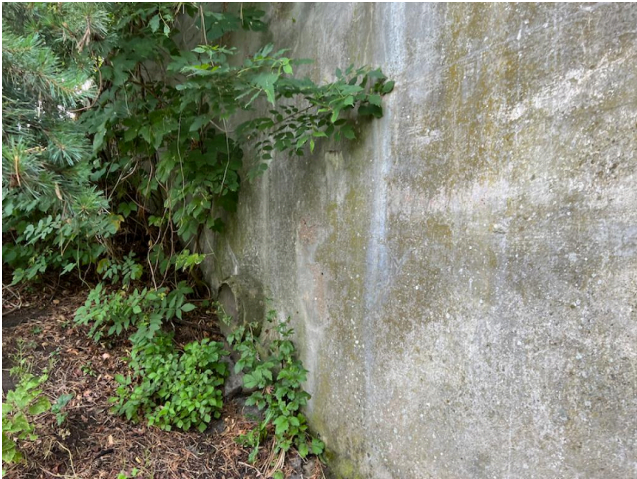
IMG_5354 - na křídlech jsou stopy po zatékání
