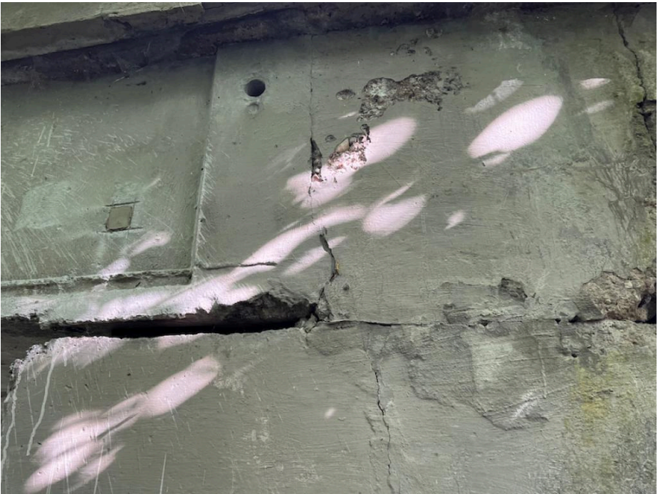
IMG_5341 - otevřená dialtační spára mezi NK a křídlem K1
