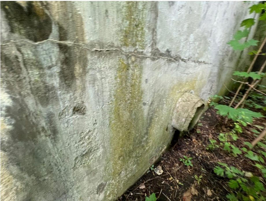
IMG_5386 - na křídle K4 se vyskytují nepravidelné trhliny do 0,3mm, lokálně výluhy
