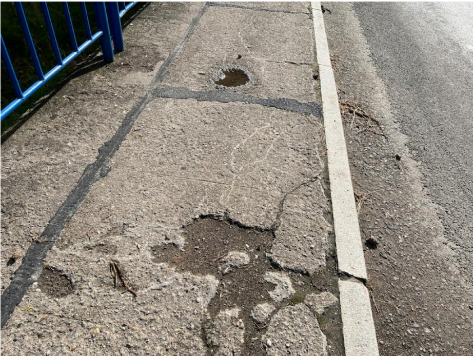
IMG_5325 - povrch pravé římsy hloubkově degraduje
