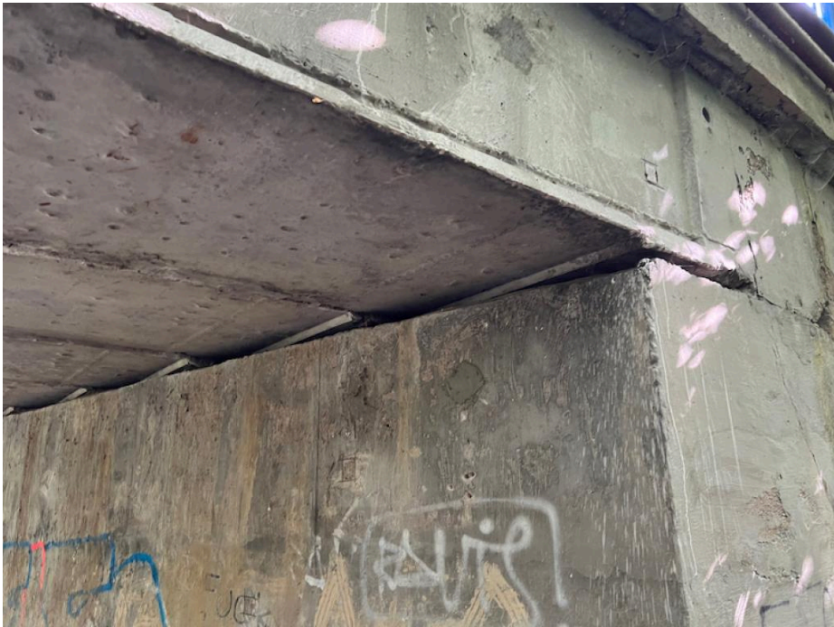
IMG_5347 - odpadlý beton a korodující výztuž na podhledu říms
