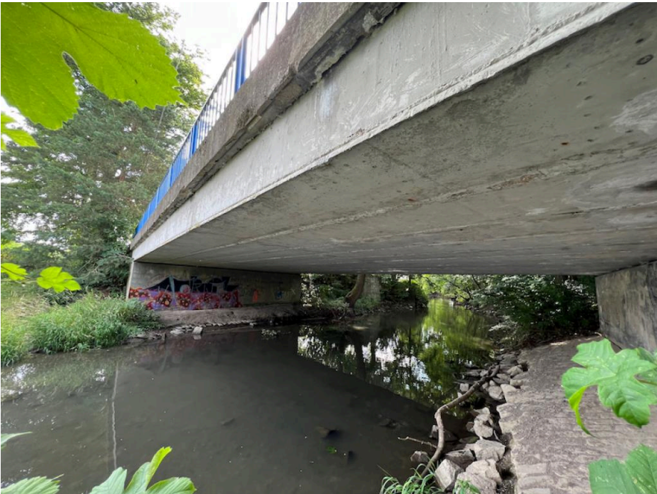
IMG_1111 - velmi zřídka patrné stopy po zatékání do NK (nejvíce pravý bok)
