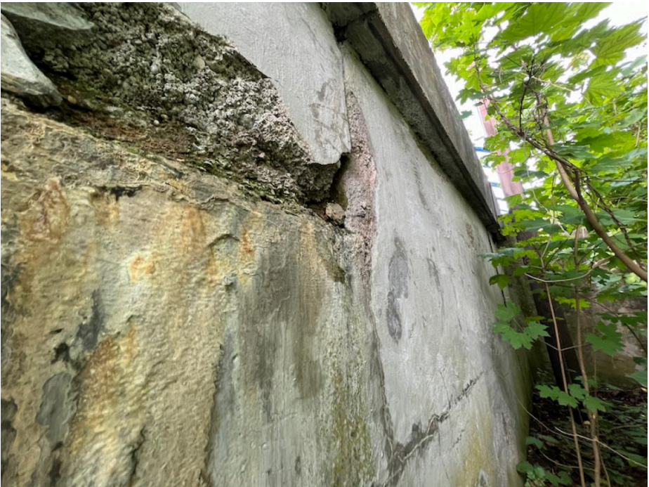
IMG_5384 - koncový příčník na konci mostu vpravo hloubkově degraduje!
