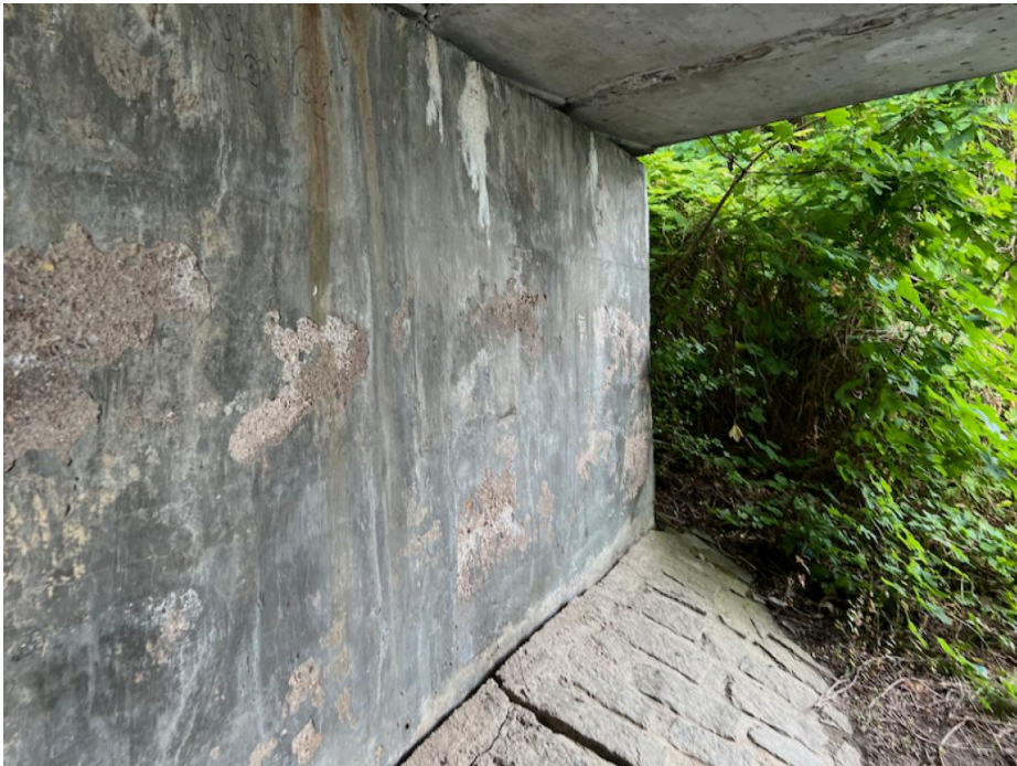
IMG_5380 - na opěře O2 jsou stopy po zatékání, lokálně výluhy
