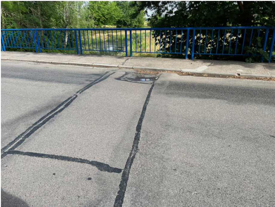
IMG_1112 - výrazný propad vozovky v okolí MZ na začátku mostu !
