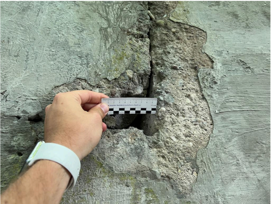
IMG_5339 - otevřená dialtační spára mezi NK a křídlem K1
