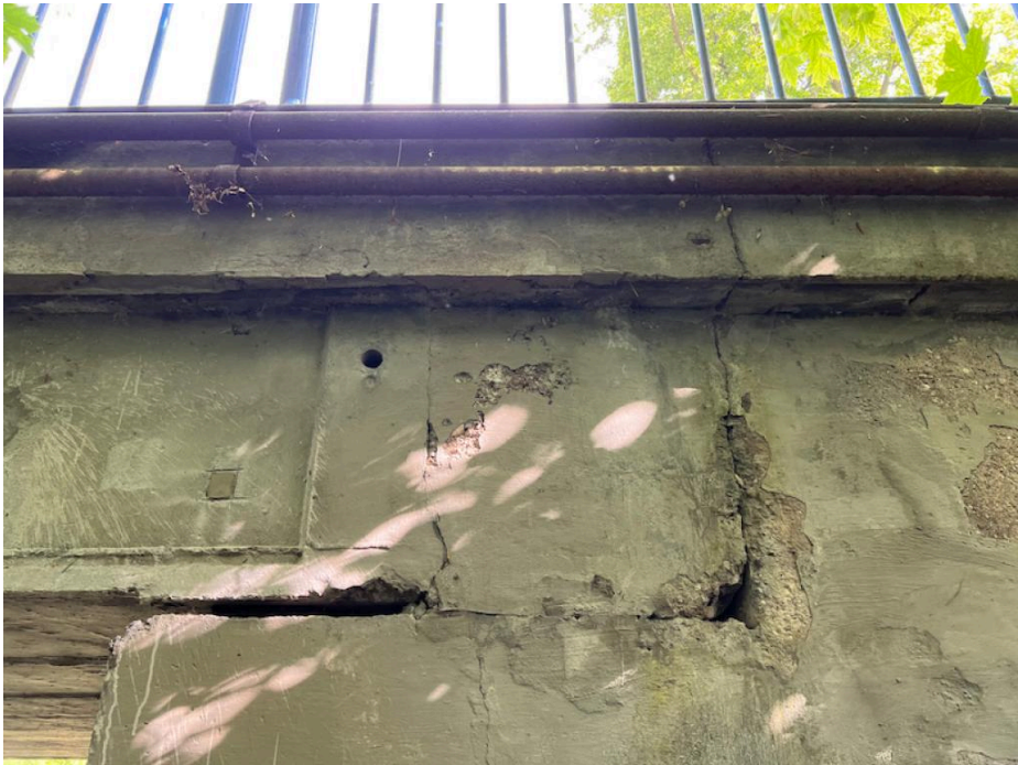
IMG_5338 - otevřená dialtační spára mezi NK a křídlem K1
