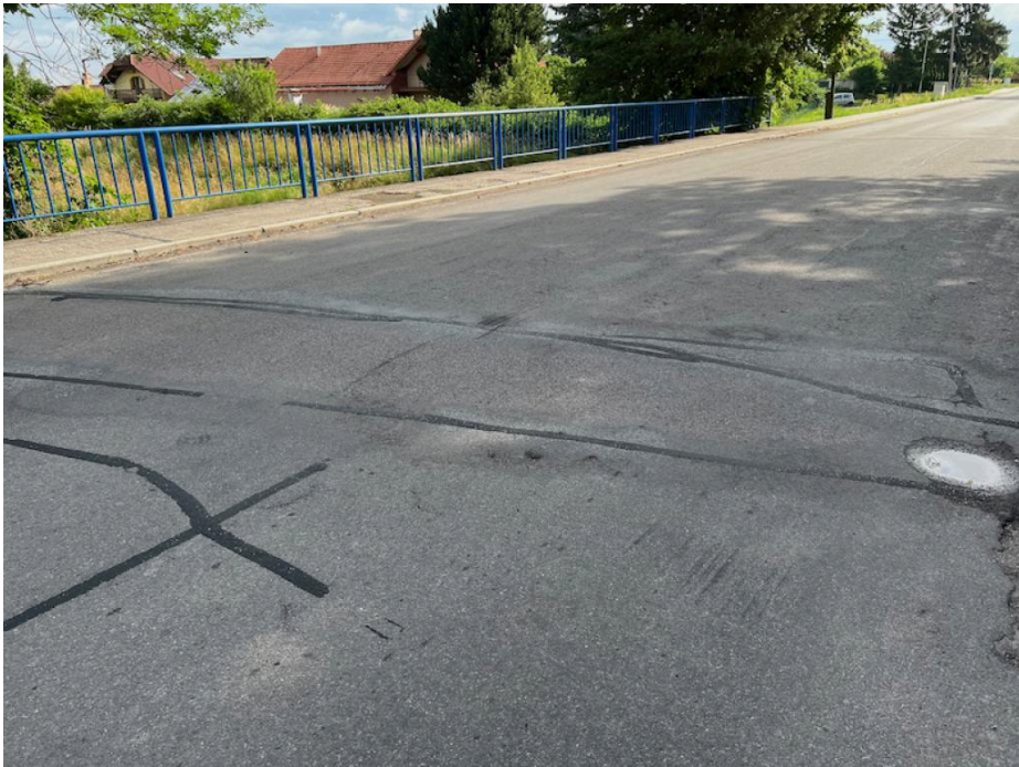
IMG_1113 - výrazný propad vozovky v okolí MZ na konci mostu !
