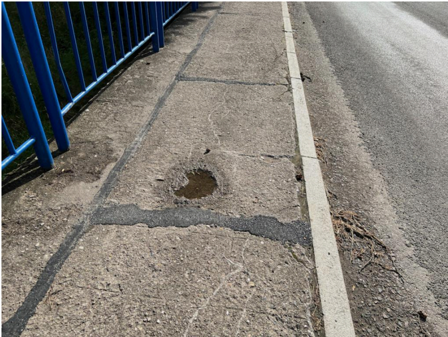
IMG_5326 - povrch pravé římsy hloubkově degraduje
