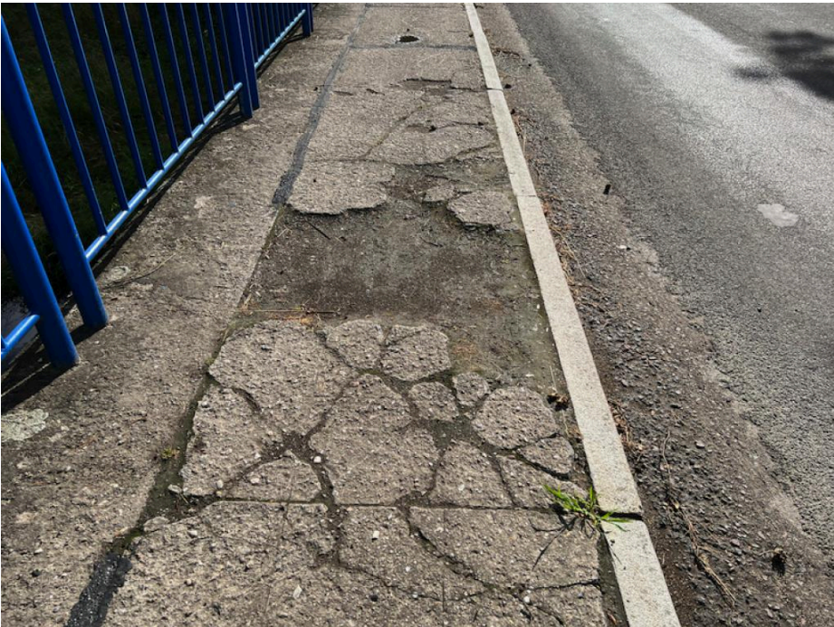
IMG_5322 - povrch pravé římsy hloubkově degraduje
