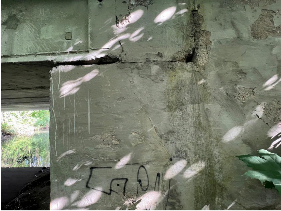
IMG_5342 - stopy po zatékání do dilatace na začátku mostu (vlevo i vpravo)
