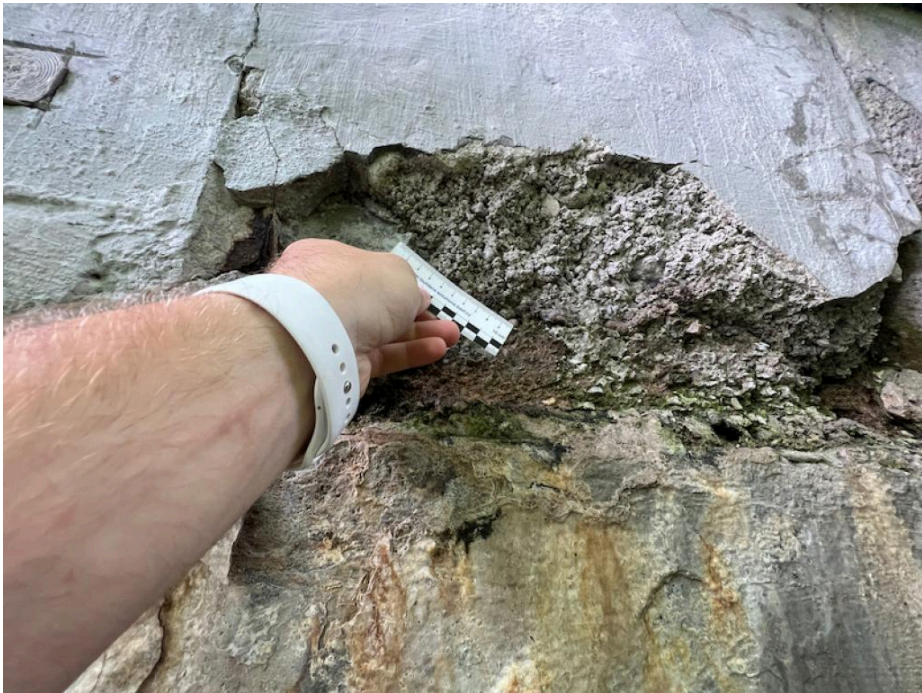
IMG_5383 - koncový příčník na konci mostu vpravo hloubkově degraduje!
